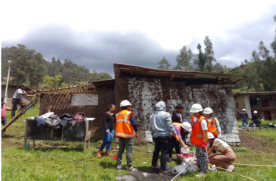
Figura 5. Estudiantes compartiendo trabajos de obra con los vecinos del lugar. Fuente: Propia.
