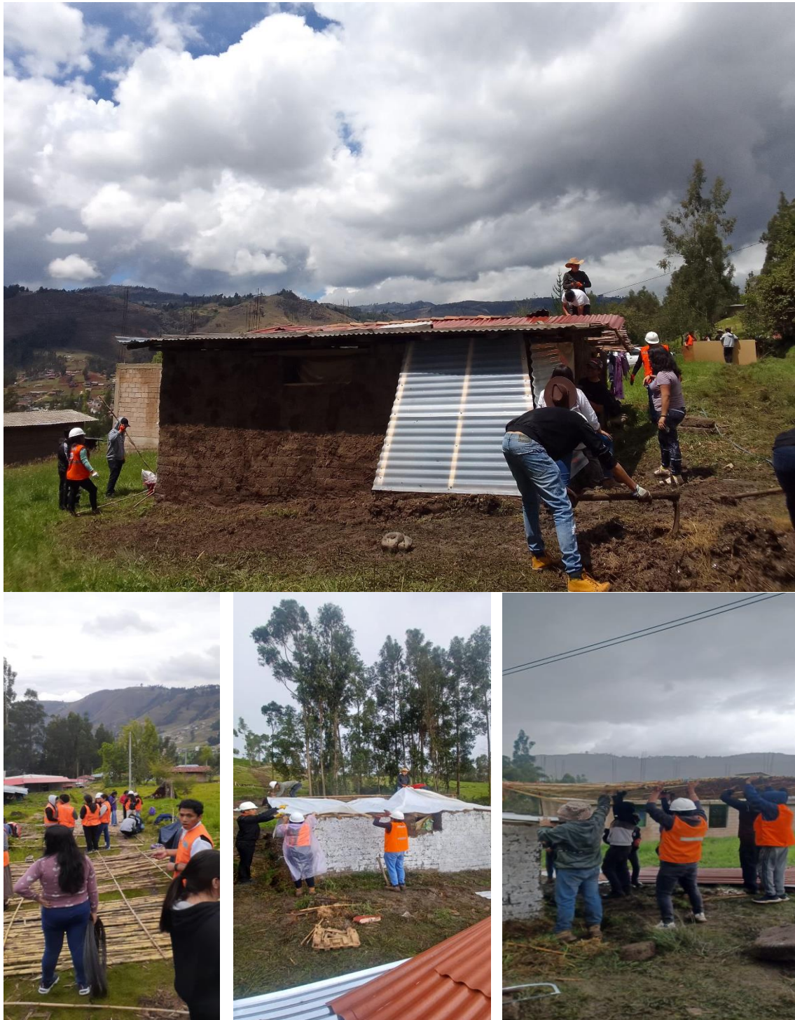
Figura 1-4. Imágenes del proceso constructivo y participación comunitaria. Fuente: Propia.
